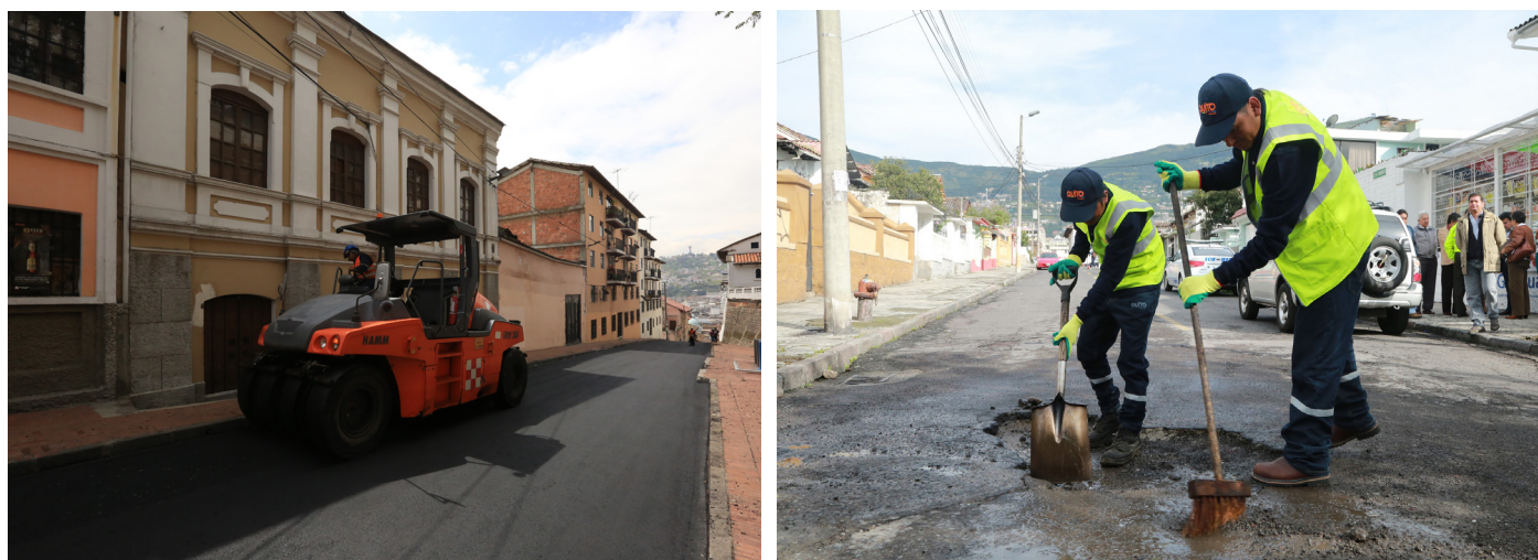
Foto: Programa de Rehabilitación y Mantenimiento Vial
